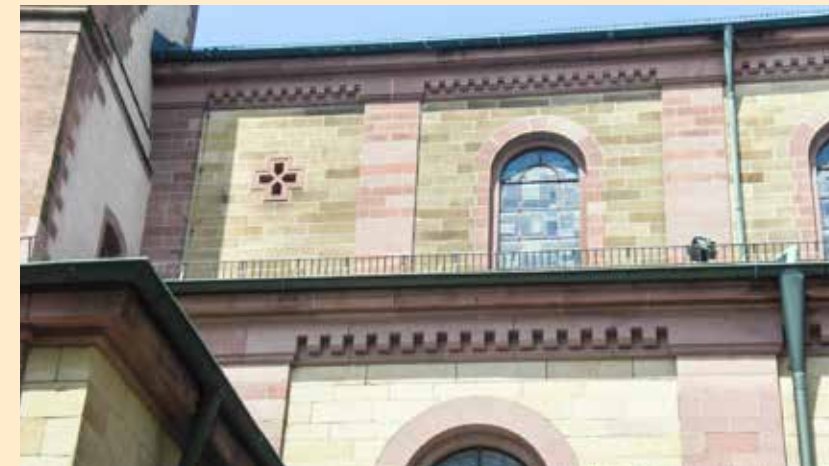
Abb. 59. Anschluss Glockenturm-Langhaus mit Abdruck des Vorgängerbaus, 2013. Foto Stadtarchiv Weinheim.
