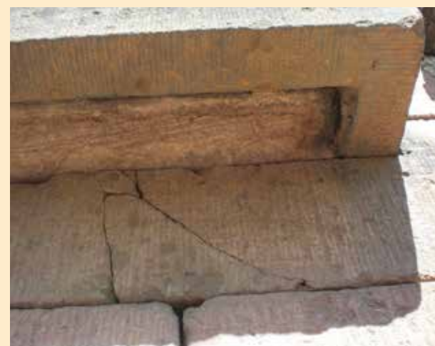
Abb. 40a. Detail: Sohlbank mit Wassernase, 2013. Foto Stadtarchiv Weinheim.
